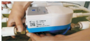
3、安装水表于管道上
