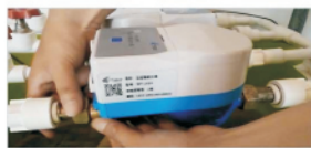
3. 安装水表于管道上
