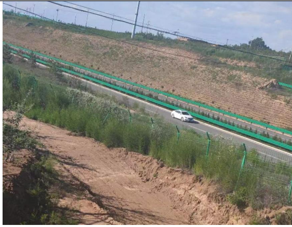
线路沿线跨越的高速公路
