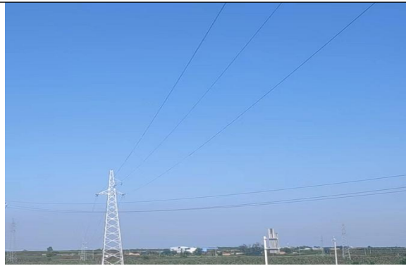
线路沿线跨越的已有输电线路
