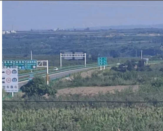
线路沿线跨越的高速公路
