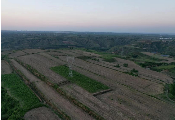
线路跨越的已有输电线路
