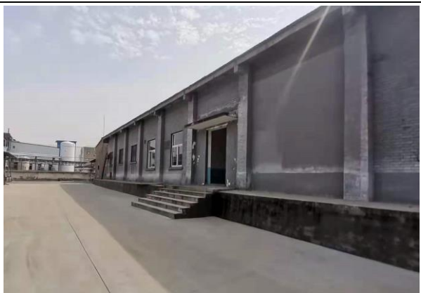
本项目利旧车间外观（北侧）
