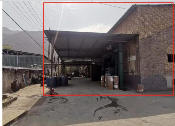
本项目利旧车间东侧（需拆除）
