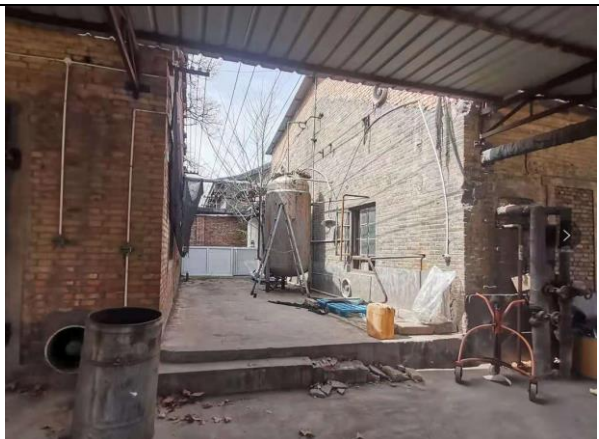
本项目利旧车间东侧遮阳棚内情况（需拆除）
