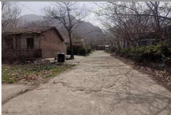
本项目利旧车间西侧厂区现有道路
