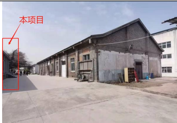
本项目北侧厂区道路及厂区其他车间
