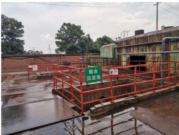
东区雨水收集池
