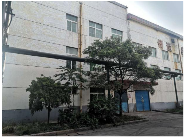
精炼车间内库房
