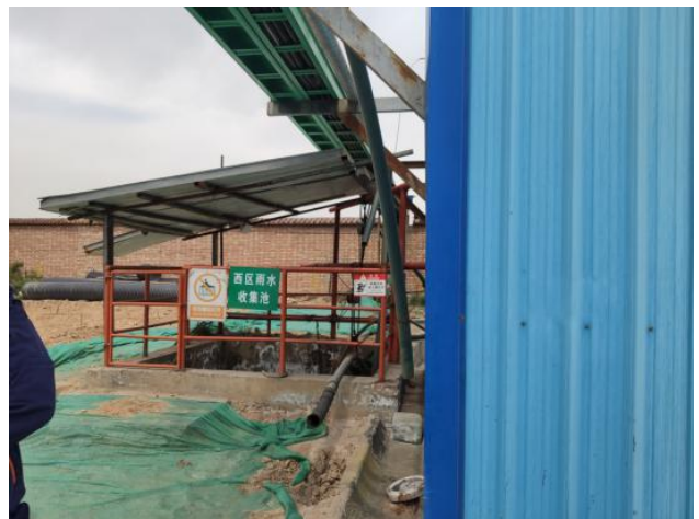
西区雨水收集池
