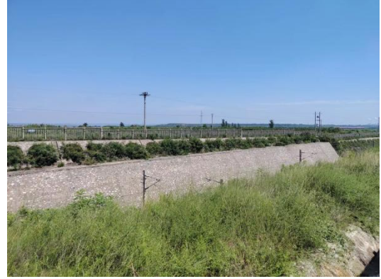
跨越包西铁路处
