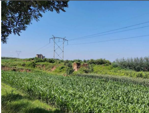
跨越 330kV 蒲泉线路处
