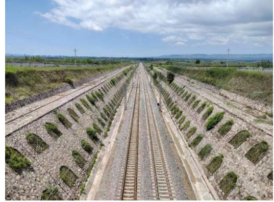
跨越黄韩侯铁路处
